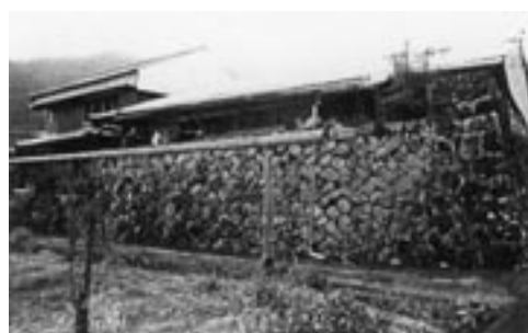
写真15 玉石による擁壁と主屋外観
