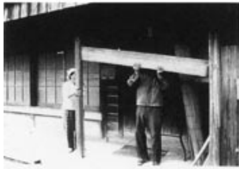
柱の間にセキイタを入れる
