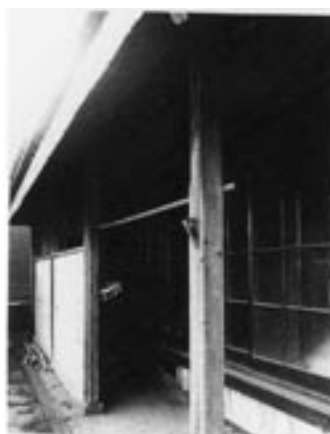
トタン張りに改変
