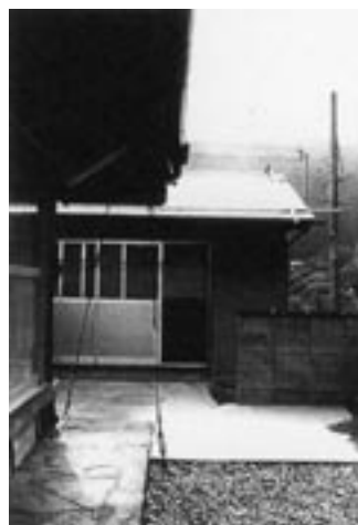
写真17 トタン屋根の押さえ棧とワイヤー
