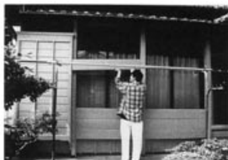
写真12 直付けセキイタ 1 (掃き出し部)
