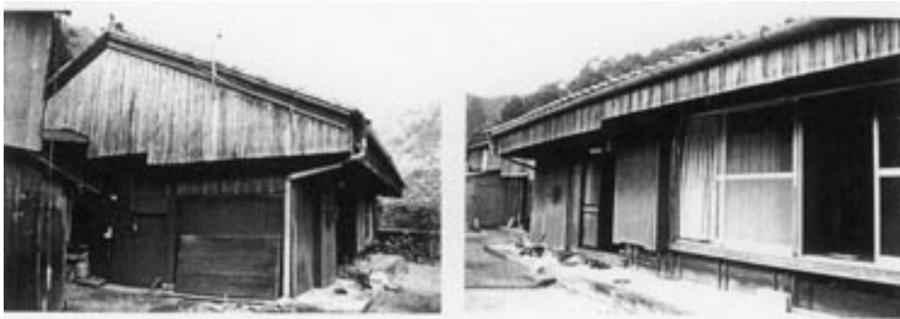
写真18 主屋の雨除け板
