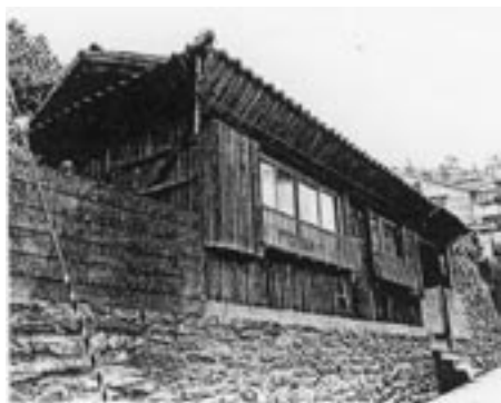
写真1 雑賀崎の軒天井
