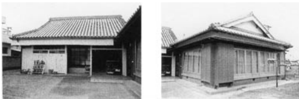
写真14 防風雨装置設置主屋と新たな外部構成要素からなる隠居所
